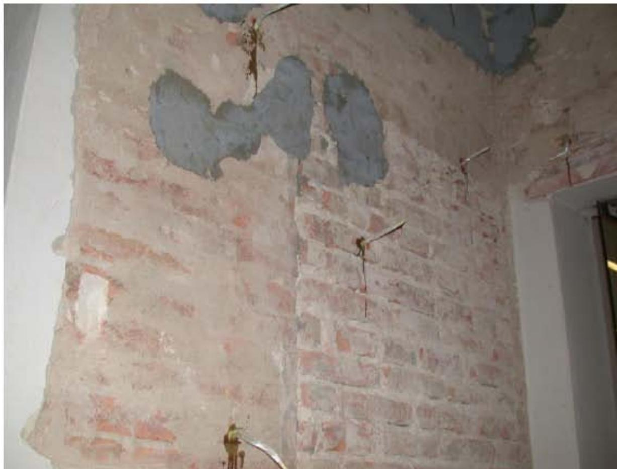
Stilatura delle fughe e stesura di una prima mano di malta strutturale bicomponente fibrorinforzata **BS 38/39 2,5 MuCis**<sup>®</sup>, spessore medio 1,5 cm.
