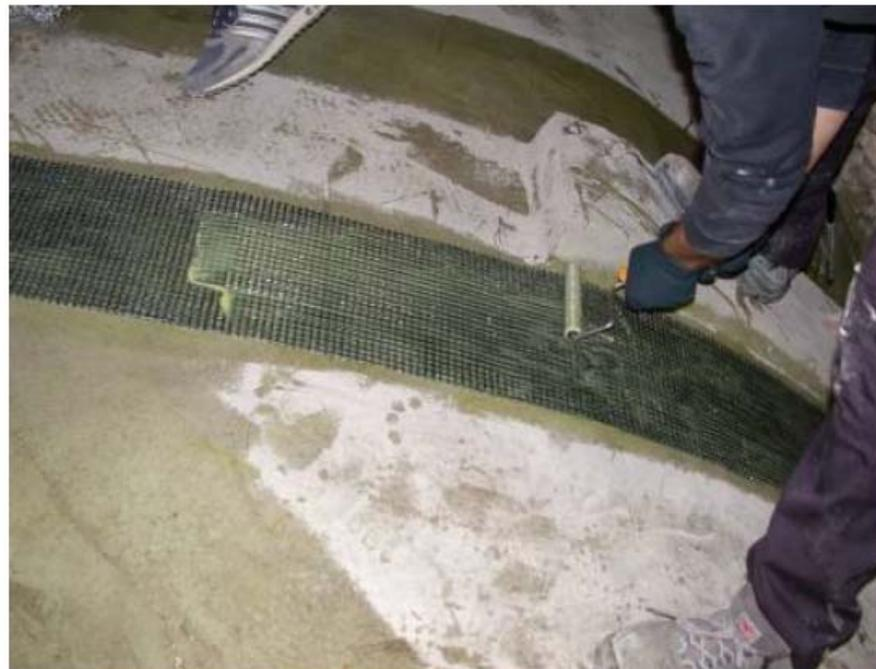
Nelle zone di riempimento perimetrali dove era previsto il passaggio delle fasce di tessuto è stata prevista la rimozione completa del riempimento esistente, l'applicazione di rasatura con malta **BS 38/39 2,5 MuCis**<sup>®</sup> e la posa dei tessuti con risvolto sulle murature portanti perimetrali.
