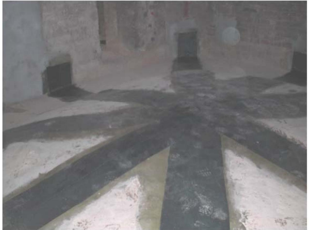
I tessuti sono stati ancorati alle murature mediante posa di connettori in fibra di carbonio **TECNOFIB FIOCCO C240**.
