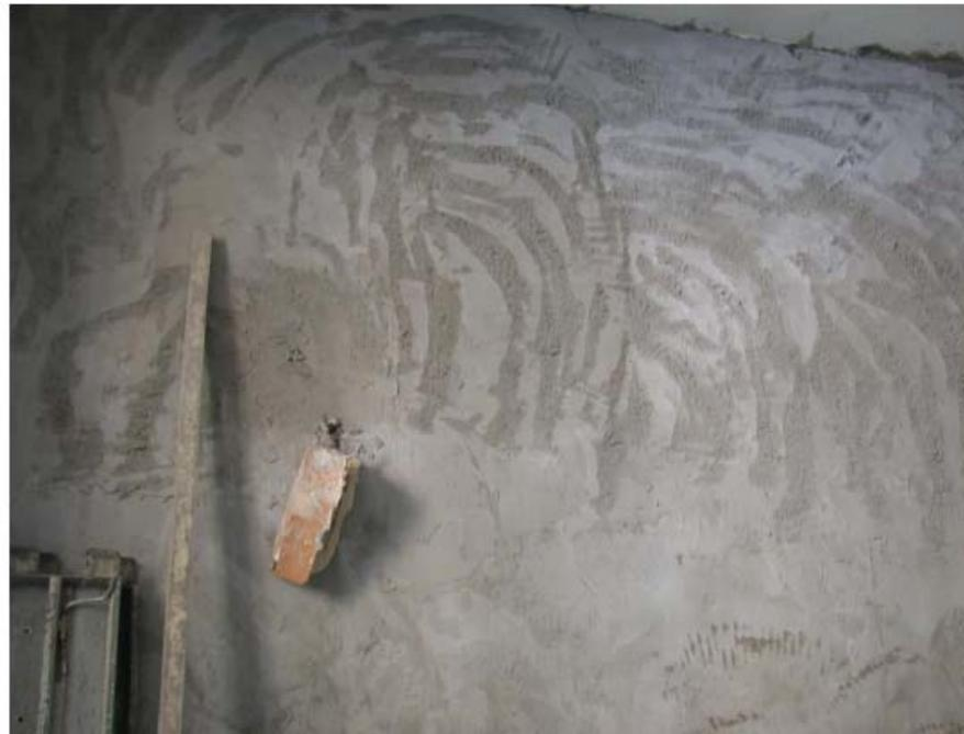
Sul fresco posizionamento e fissaggio della rete in fibra di vetro bidirezionale con trattamento antialcali **TECNOFIB GLASS NET 510**. I fiocchi precedentemente posati vengono fatti passare attraverso le maglie della rete per essere poi fissati in una fase successiva.
