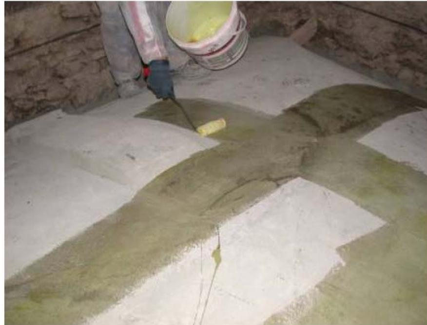
**TECNOEPO 701**, resina a base epossiamminica, formulata quale adesivo, bicomponente ed indurente a temperatura ambiente con un consumo di circa 700 g/m<sup>2</sup>.
